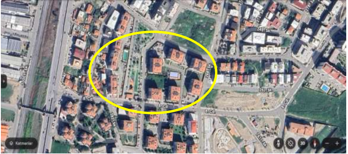
Şekil 1. Örnek uygulama alanı (E... Konut Yapı Kooperatifi)
