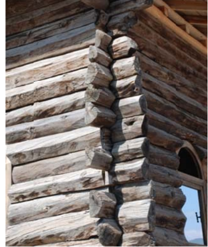
Resim 5- 6. Balıkesir İli, Kızılcabayır Camii genel görünüm ve çantı tekniği
