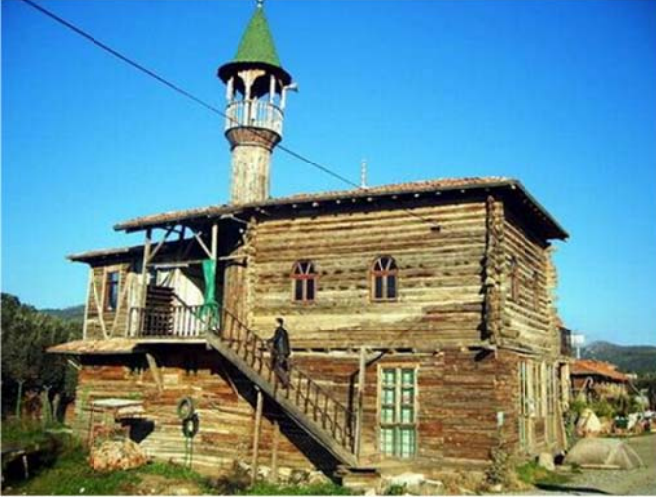
Resim 5- 6. Balıkesir İli, Kızılcabayır Camii genel görünüm ve çantı tekniği
