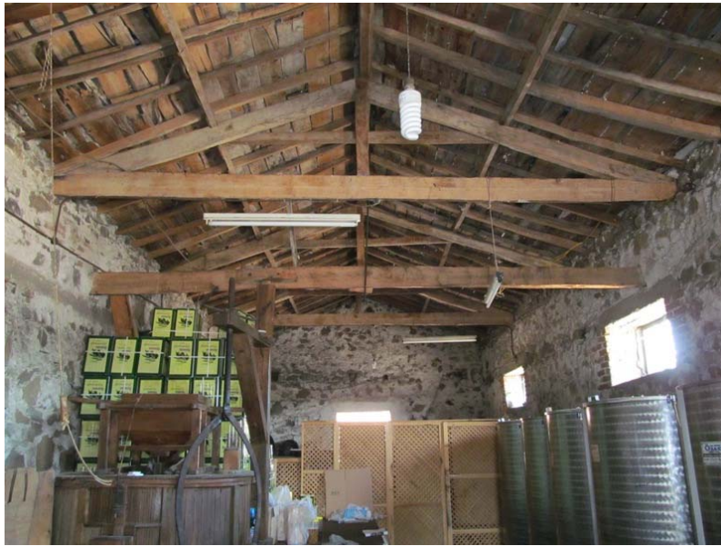
Şekil 5. Yapının özgün çatı konstrüksiyonundan görünüm.
