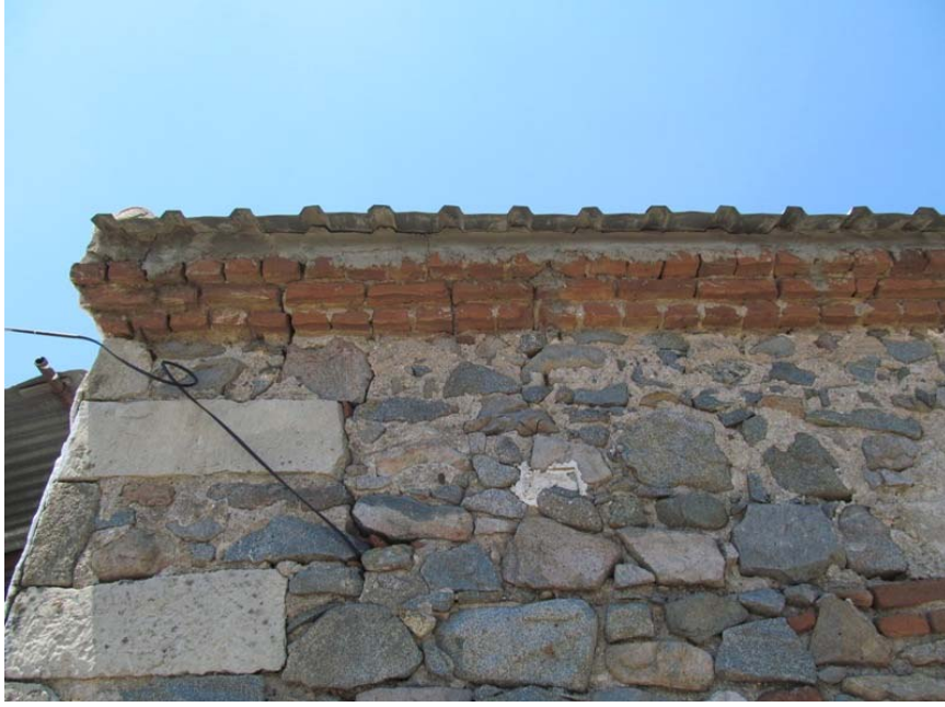
Şekil 4. Yapıya ait kirpi saçaktan görünüm.
