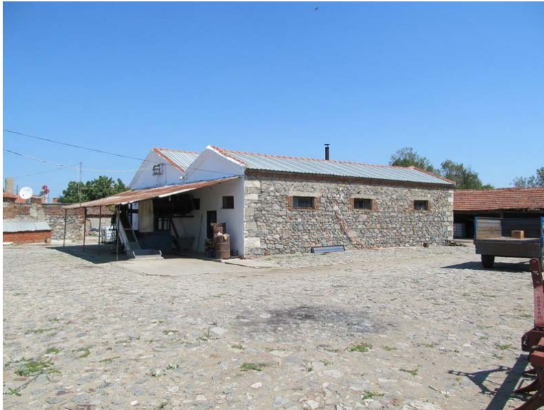
Şekil 2. İmalathane binasının güneydoğu yönünden görünümü.
