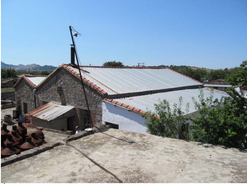
Şekil 12. İmalathanenin batı cephesine bitişik olarak inşa edilen mekandan görünüm.
