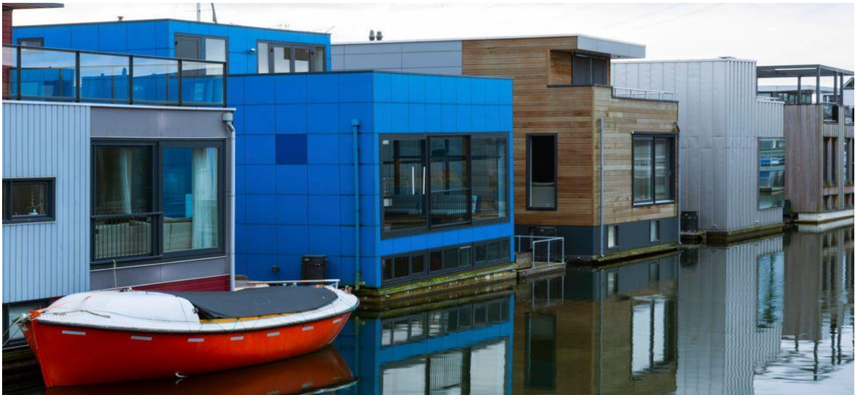
Resim 6. Hollanda'nın yüzen evleri bir sütuna bağlıdır ve su seviyesine göre sütunda yukarı ve aşağı hareket edebilmektedir (Getty Images)
