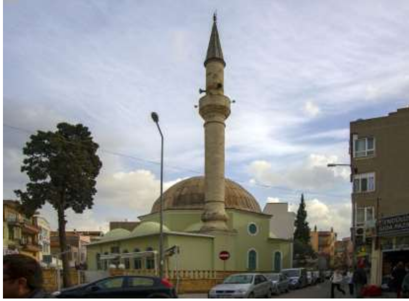
Şekil 12. Kurşunlu Cami Genel Görünüm (Mimar Erdem Salcan Arşivi, 2023).
