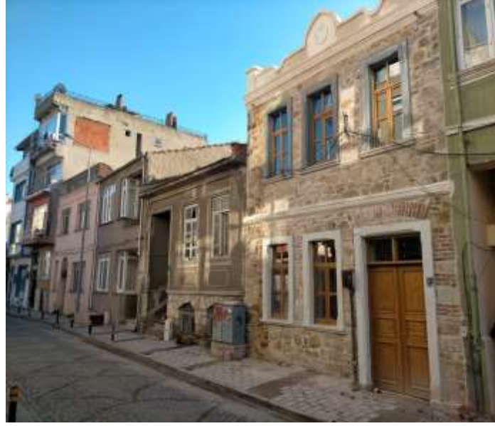
Şekil 10. Büyük (Fatih) Cami ile Tıflı Camii - Kilise (Zafer) Meydanını Bağlayan Büyük Hamam Sokakta Yer Alan Geleneksel Mimari Yapılardan Görünüm (Mimar Erdem Salcan Arşivi, 2023).
